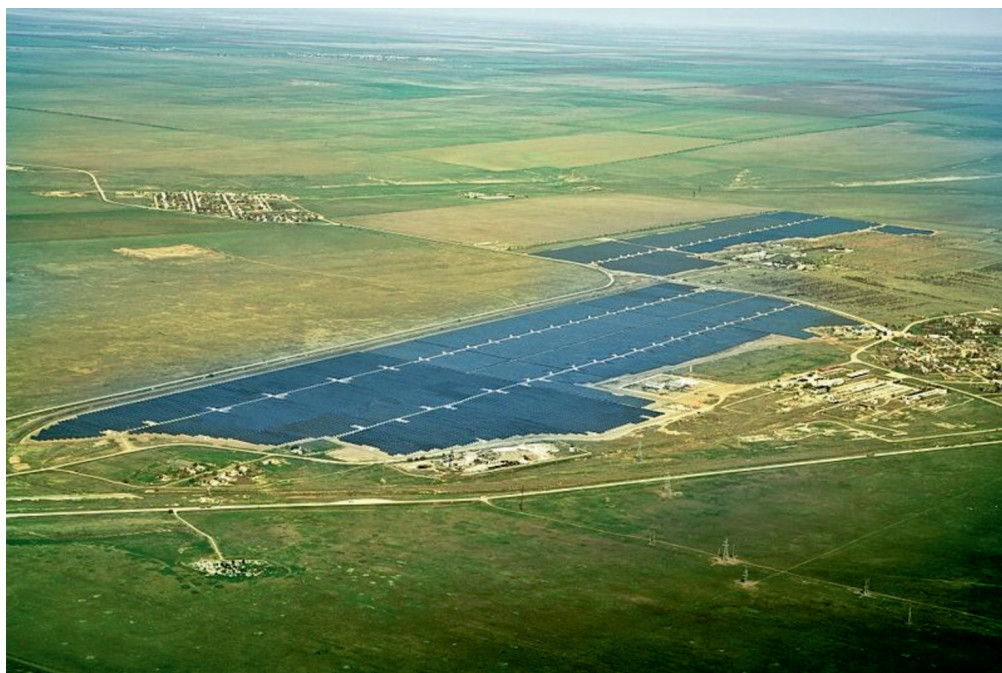
Рис. 2. Солнечная электростанция в с. Охотниково
