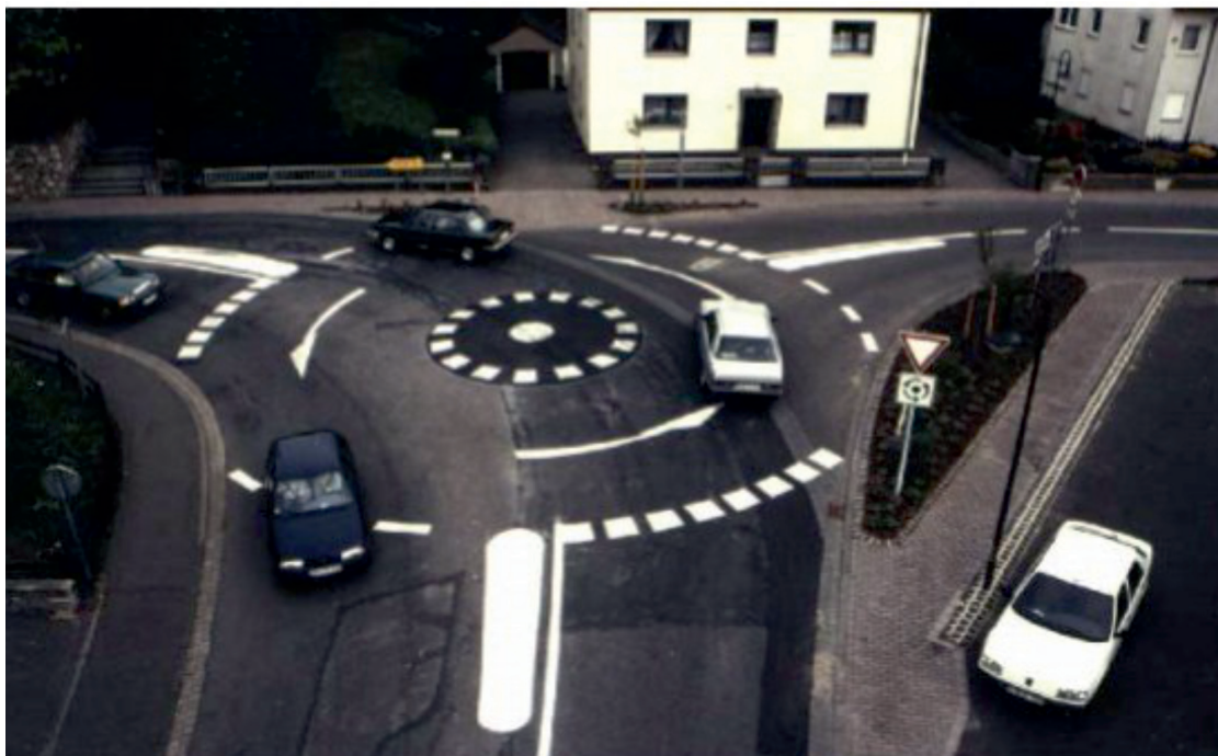
Рис. 5. Германия. Пример мини-колец, который применяется в городских условиях. Кольцевое пересечение фактически вписывается в габариты обычного перекрестка. Приподнятый на несколько сантиметров центральный островок выделен разметкой и позволяет движение длинномерных транспортных средств
