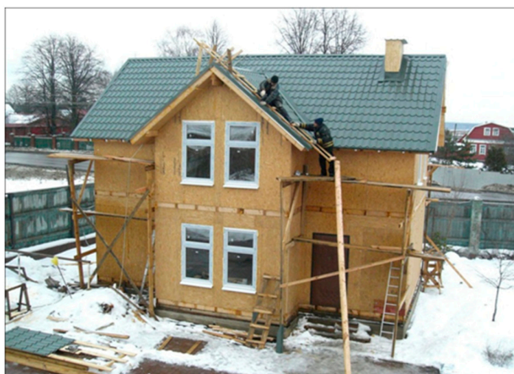
Рис. 13. Монтаж индивидуального жилого дома по экспериментальной технологии из сэндвич-панелей повышенной степени заводской готовности, соединенных инновационными гибкими узлами типа «муфта-гильза»
