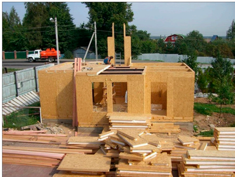
Рис. 12. Экспериментальная установка наружных стеновых панелей из сэндвич-панелей размером 1,2 x 3,6 м в индивидуальном жилом доме
