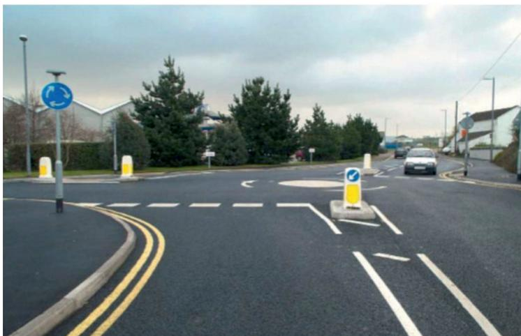
Рис. 2. Типичный внешний вид мини-кольца с разметками TSRGD 1003.4 (центральный островок) и TSRGD 1003.3 (стоп-линия). Слева на стойке установлен знак «круговое движение» TSRGD
