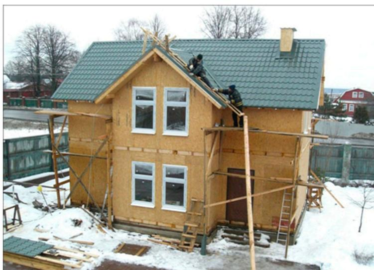
*Рис. 13. Монтаж индивидуального жилого дома по экспериментальной технологии из сэндвич-панелей повышенной степени заводской готовности, соединенных инновационными гибкими узлами типа «муфта-гильза»*
