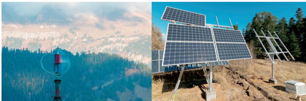
Рис. 4. Ветро-солнечная электростанция на метеостанции «Джуга»
