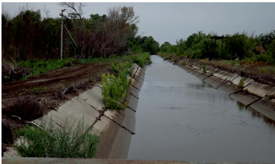
*Рис. 3. Горизонтальное расположение плит сборной железобетонной облицовки (Заволжская ООС)*
