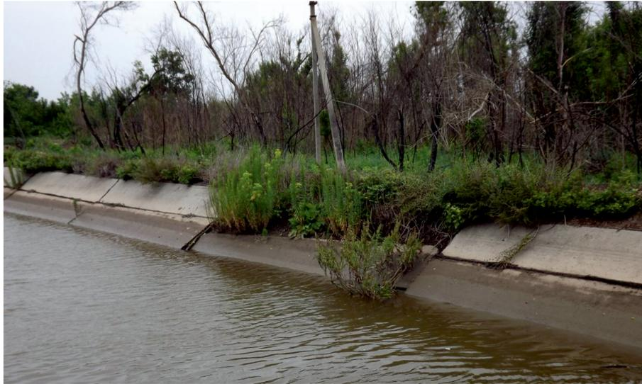
Рис. 4. Размыв основания железобетонной облицовки и сползание железобетонных плит
