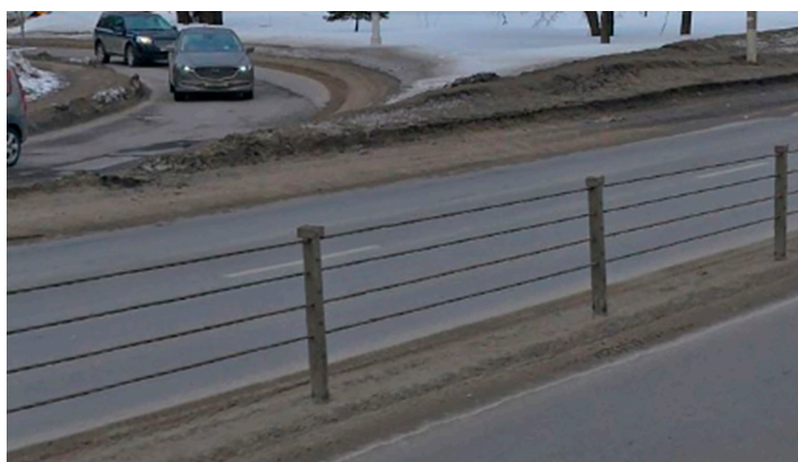
Рис. 3. Тросовое дорожное ограждение
