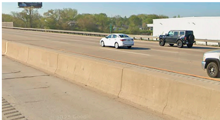
Рис. 2. Парапетное дорожное ограждение
