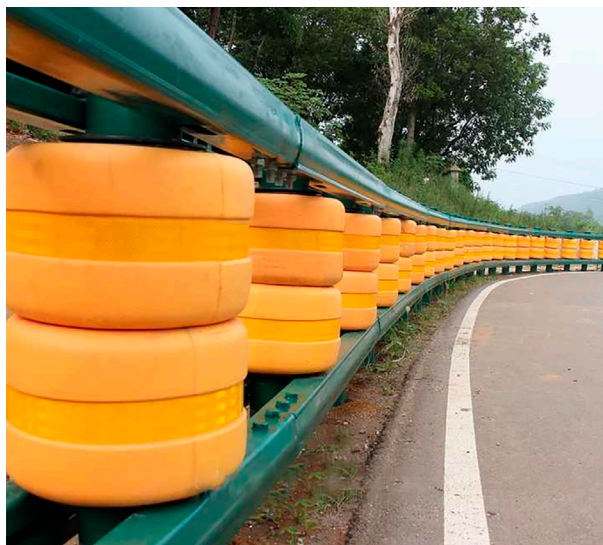
Рис. 4. Роликовое дорожное ограждение
